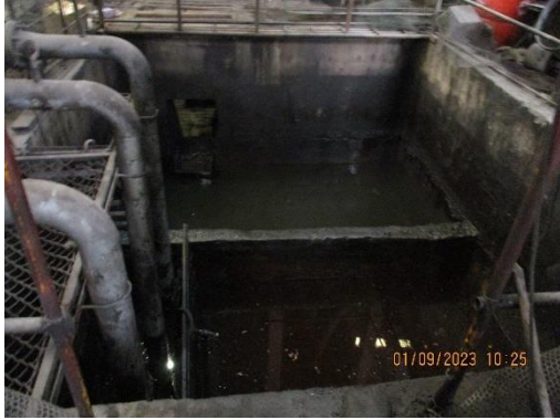
รูปที่ 7 บ่อดักไขมันและบ่อดักตะกอนใต้แท่นเครื่องหล่อ
