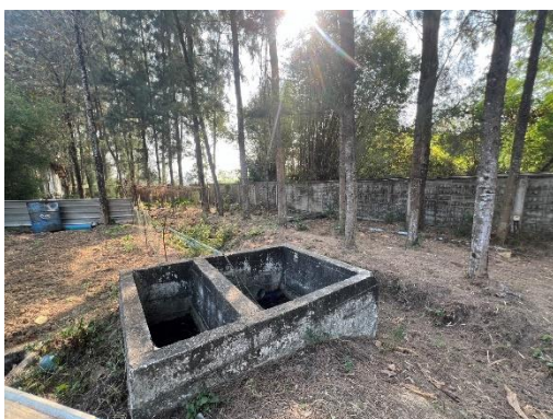
รูปที่ 23 บ่อดักไขมันบริเวณกองเหล็ก
