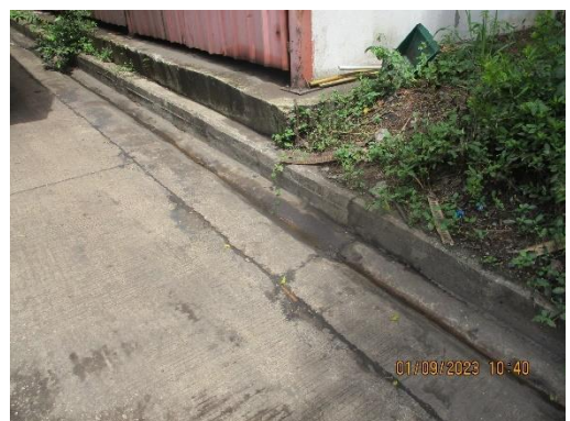
รูปที่ 24 รางรับน้ำรอบพื้นที่กักเก็บถ่านโค้ก
